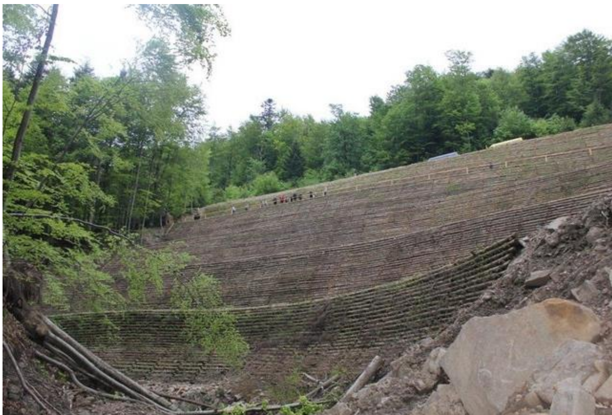
Stabilizacja osuwiska w ndl. Stuposiany. Fot. ze strony internetowej RDLP w Krośnie
